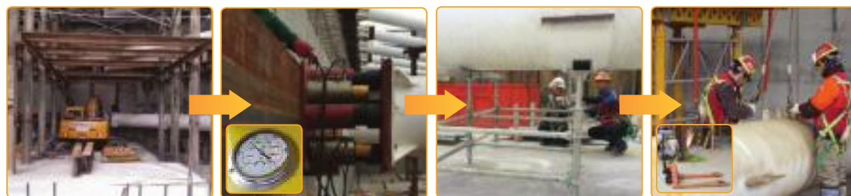
▲ 지하층 건축 SLAB 시공 ▲ 선행하중제 압력제거 ▲ PPS 해체 ▲ PPS 해체 (운반 및 인양)
