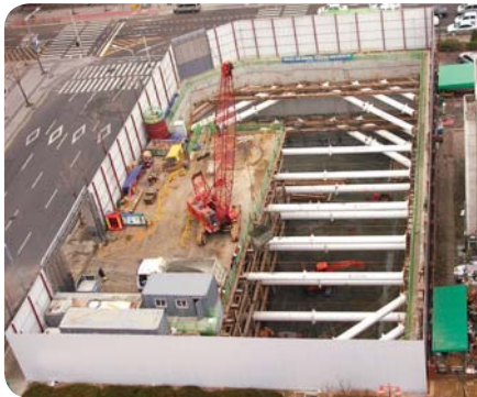
International Temple stay · Excavation depth : 14~20m · PPS installation layer & length : 2 layer / 630m · PPS diameter : Ø 800mm
