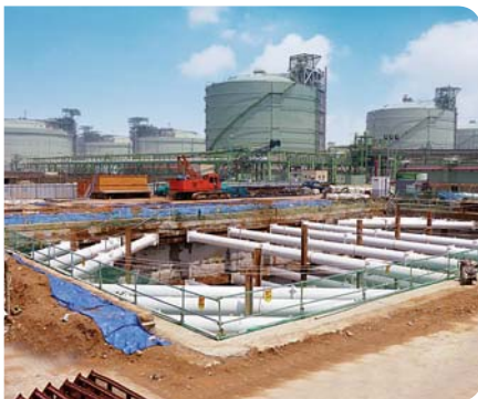
LNG Tank Terminal, Pyeongtaek · Excavation depth : 15.5~20.9m · PPS installation layer & length : 3~4 layer / 840m · PPS diameter : Ø 800mm
