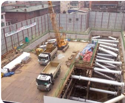
Bulgwangsa, Seoul · Excavation depth : 20.5~22.9m · PPS installation layer & length : 3 layer / 711m · PPS diameter : Ø 800mm
