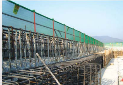
콘크리트띠장 철근조립 및 거푸집설치
