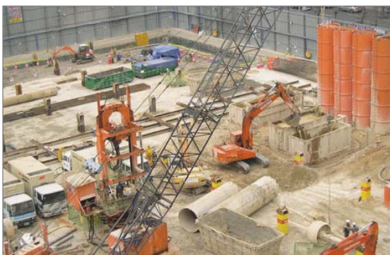
굿모닝시티 RCD 시공전경
