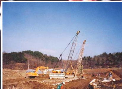
속초 취수장 지하댐 설치공사
