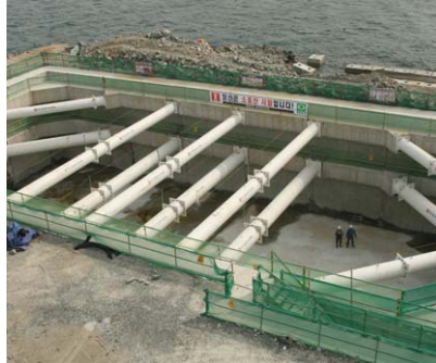
부산 북항대교 민간투자사업 (MP-3 주탑기초공사)
