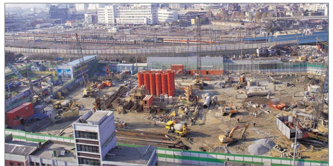
한강로 벽산주상복합 바렛 시공전경
