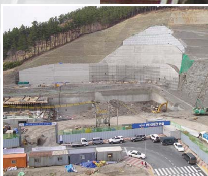
포항 코아루아파트 단지토목
