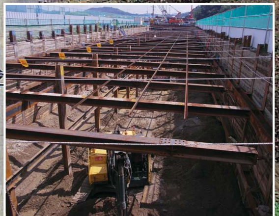
수도권 고속철도 (수서~평택) 1~2공구 터널및 개착박스공사
