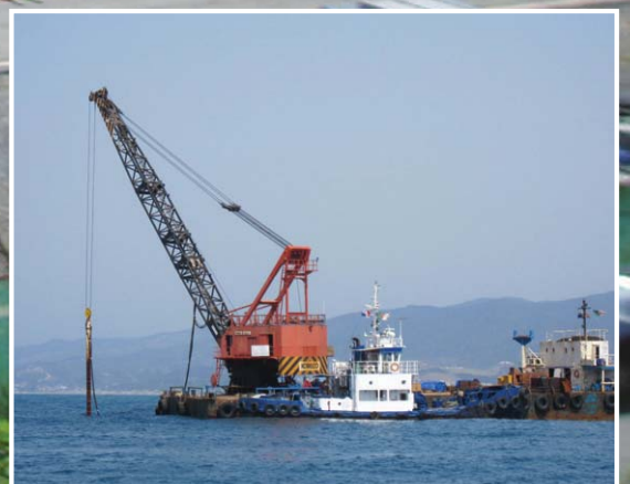
알제리 쟈젠항 방파제 증축공사 중 기초지반 개량공사
