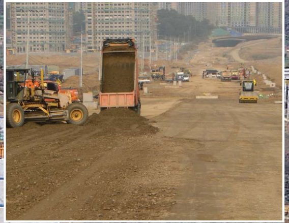
광교 택지부지 조성공사(4공구)
