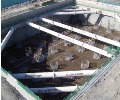
부산 북항대교 민간투자사업 (MP-2 주탑기초공사)
