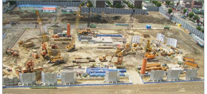
인천 푸림엑스루타워 RCD 시공전경
