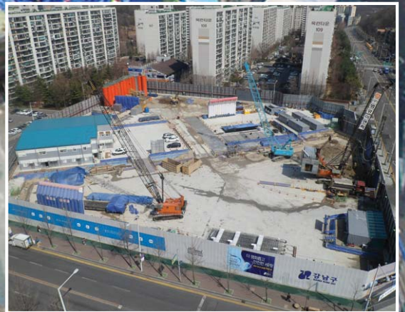
일원동 삼성생명사옥 지하연속벽
