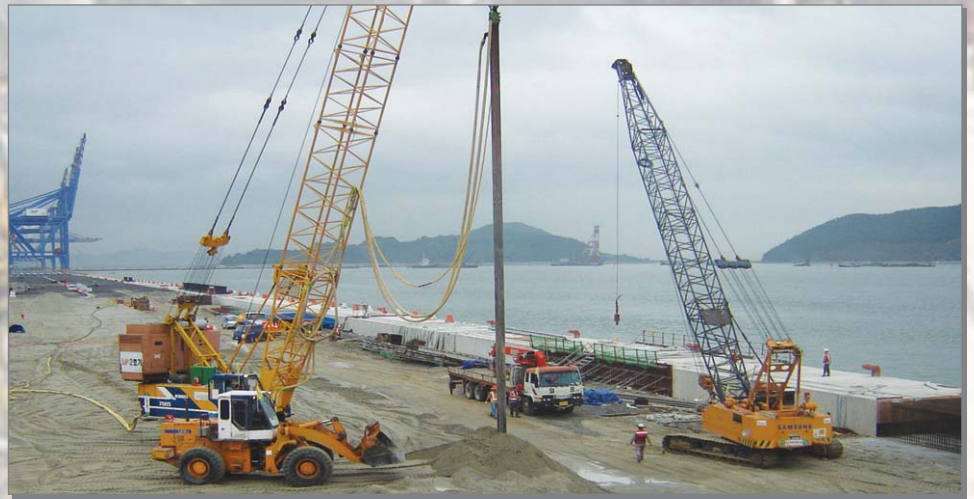
부산신항 1-2단계 압박매면 진동다짐 현장 시공전경, 2006년 (주)범양이엔씨
