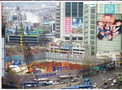
경주농수산물 시장 지하공사
