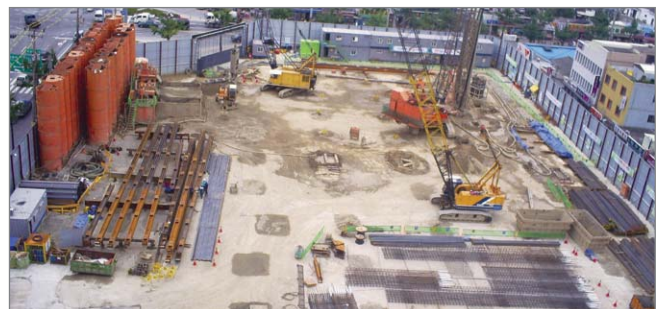
강릉시네마애펀션 바렛파일 시공전경
