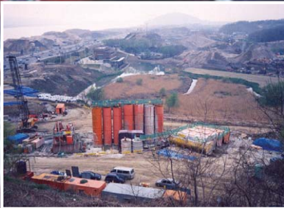
난지도 쓰레기 처리장 침출수 차수벽공사
