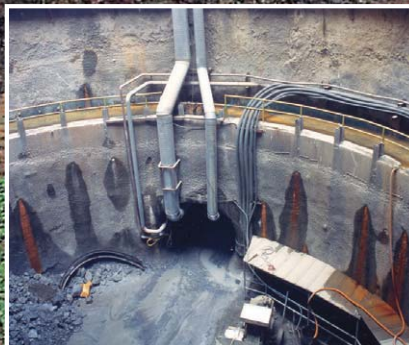
NATM 터널 Shaft
