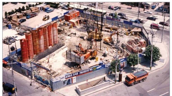
부산하단 삼성전자사옥 바렛파일 시공전경
