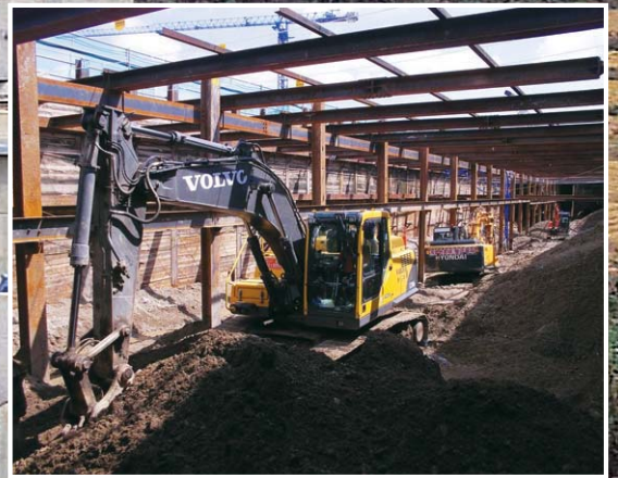
수도권 고속철도 (수서~평택) 1~2공구 터널및 개착박스공사
