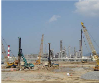
여수 CS 칼텍스 VDU TANK 스톤컬럼현장
