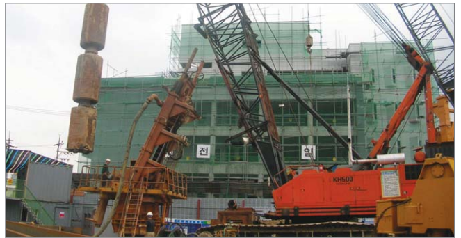
망우동 한일주거복합빌딩 RCD시공
