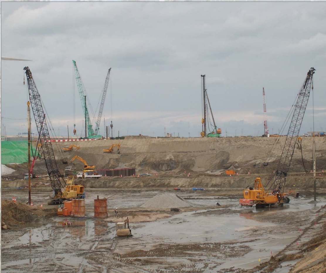
군산 조선소 도로 하부구조 스톤컬럼 공사
