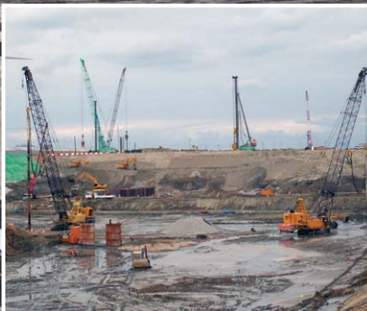
군산 조선소 도크 하부기초 스톤컬럼 공사
