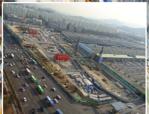
가락시장 시설현대화사업 지하연속벽, PRD, 토공사
