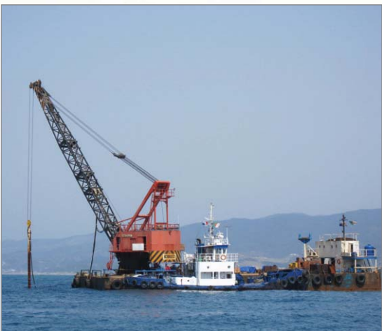
알제리 전진항 방파제 증축공사 중 기초지반 개량공사
